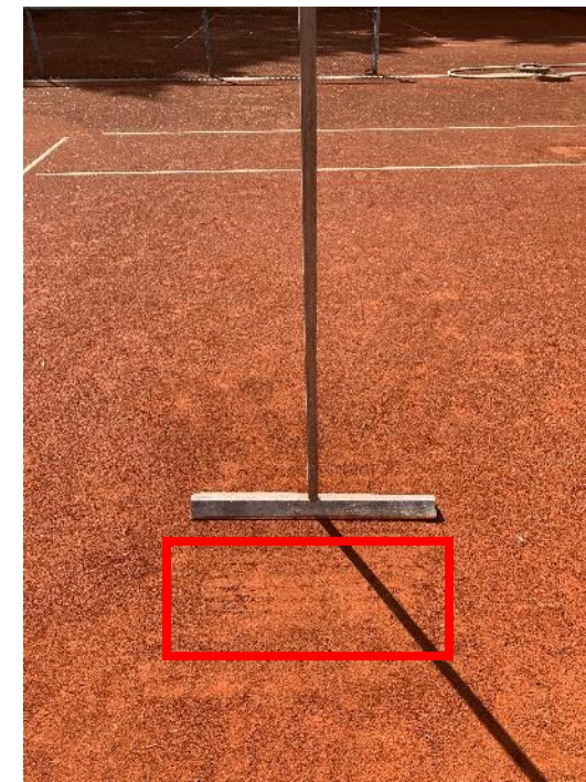
Mit der Unterseite des Kantholzes den Sand festklopfen, dann Platz abziehen
